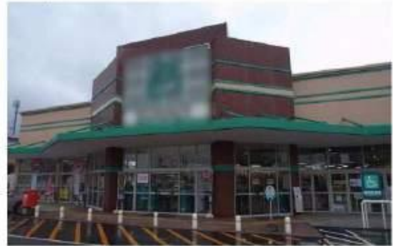
Premaz na krovu supermarketa
