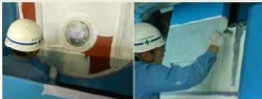
Proces nanošenja premaza
