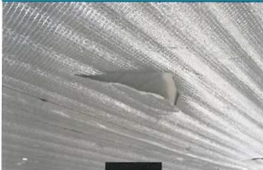
Preventivni sloj protiv kondenzacije vodene pare
