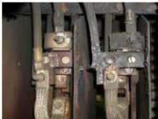
▲ Pokvaren prekidač uslijed kondenzacije vodene pare.
